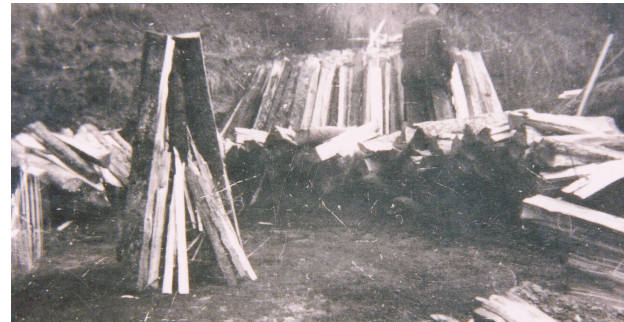
Aufrichten des Meilers mit Schacht in der Mitte (Fotoarchiv Georg Knöpfle)
