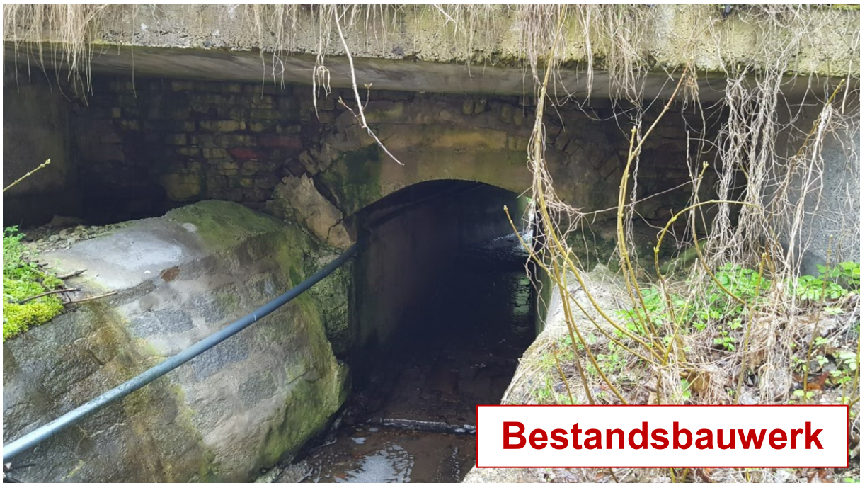
Foto: Nowak, Tiefbauverwaltung
