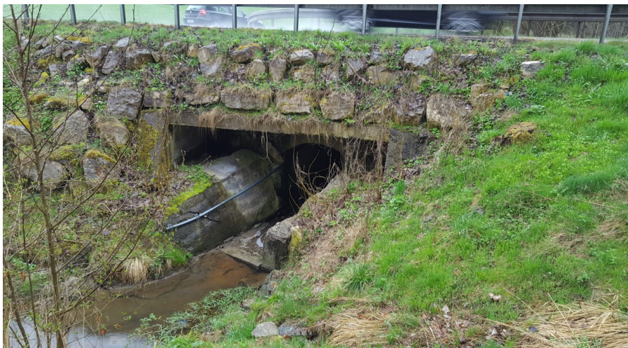
Foto: Nowak, Tiefbauverwaltung
