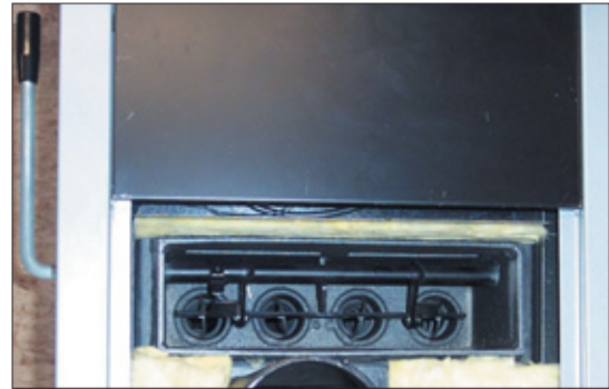
Abb. 8: Röhrenwärmetauscher mit Turbulatoren, die zur Reinigung der Heizgaszüge mittels Hebelvorrichtung vor- und zurückbewegt werden
